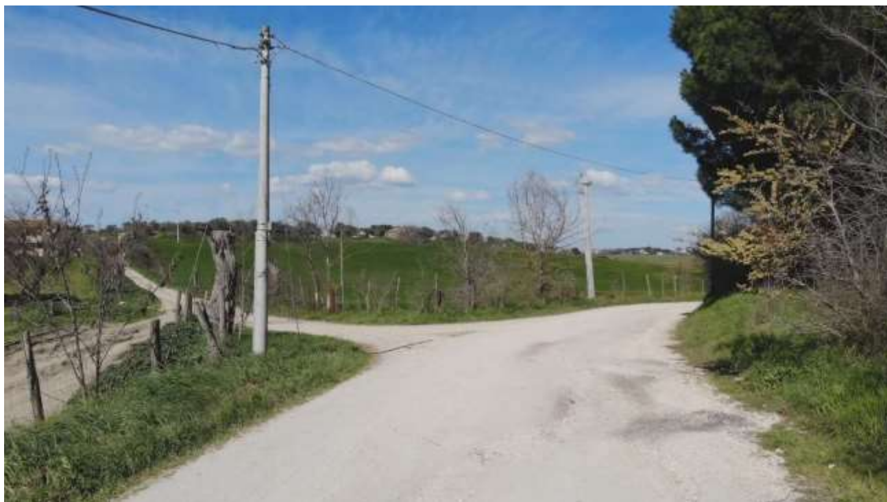
Figura 12 Stato attuale della via dell'Inviolata nel tratto da via di Casal Bianco verso l'impianto TMB di proprietà di Pontina Ambiente
