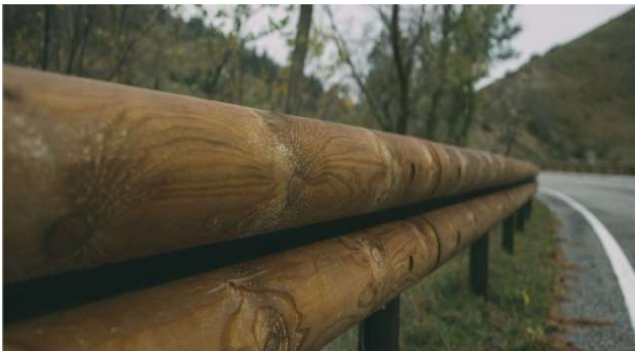
Figura 19 Barriera stradale in acciaio CORTEN e legno
