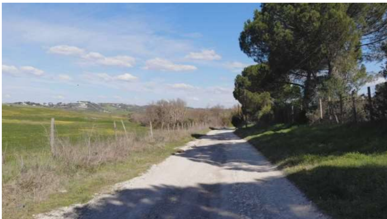
Figura 14 Stato attuale della via dell'Inviolata nel tratto da via di Casal Bianco verso l'impianto TMB di proprietà di Pontina Ambiente
