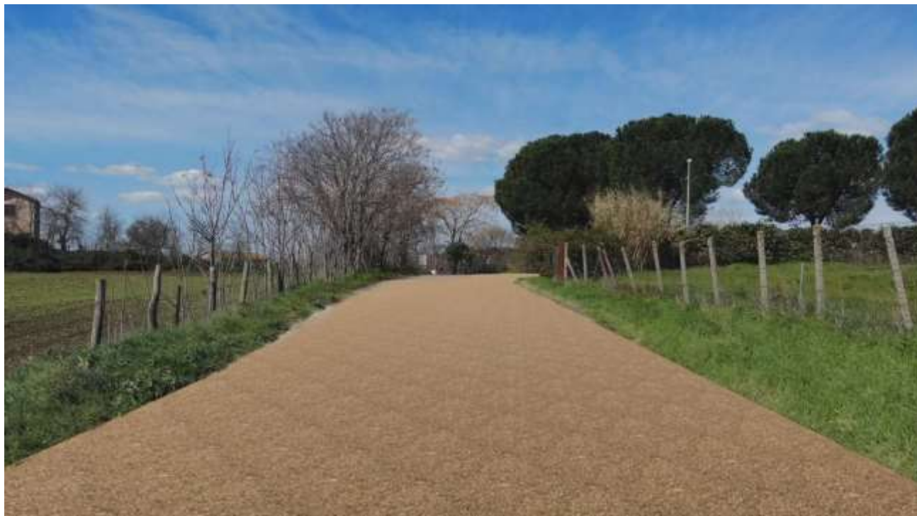
Figura 233 Tipico Post Operam della via dell'Inviolata nel tratto da via di Casal Bianco verso l'impianto TMB di proprietà di Pontina Ambiente
