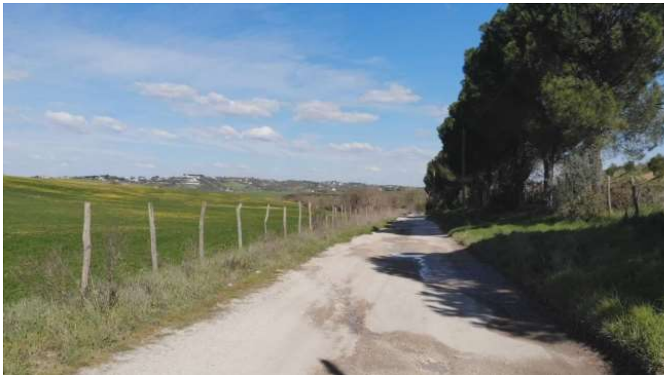
Figura 13 Stato attuale della via dell'Inviolata nel tratto da via di Casal Bianco verso l'impianto TMB di proprietà di Pontina Ambiente
