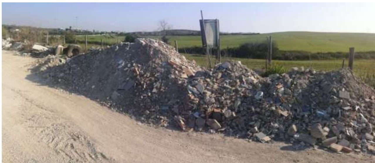
Figura 10 Stato attuale della via dell'Inviolata nel tratto da via di Casal Bianco verso l'impianto TMB di proprietà di Pontina Ambiente
