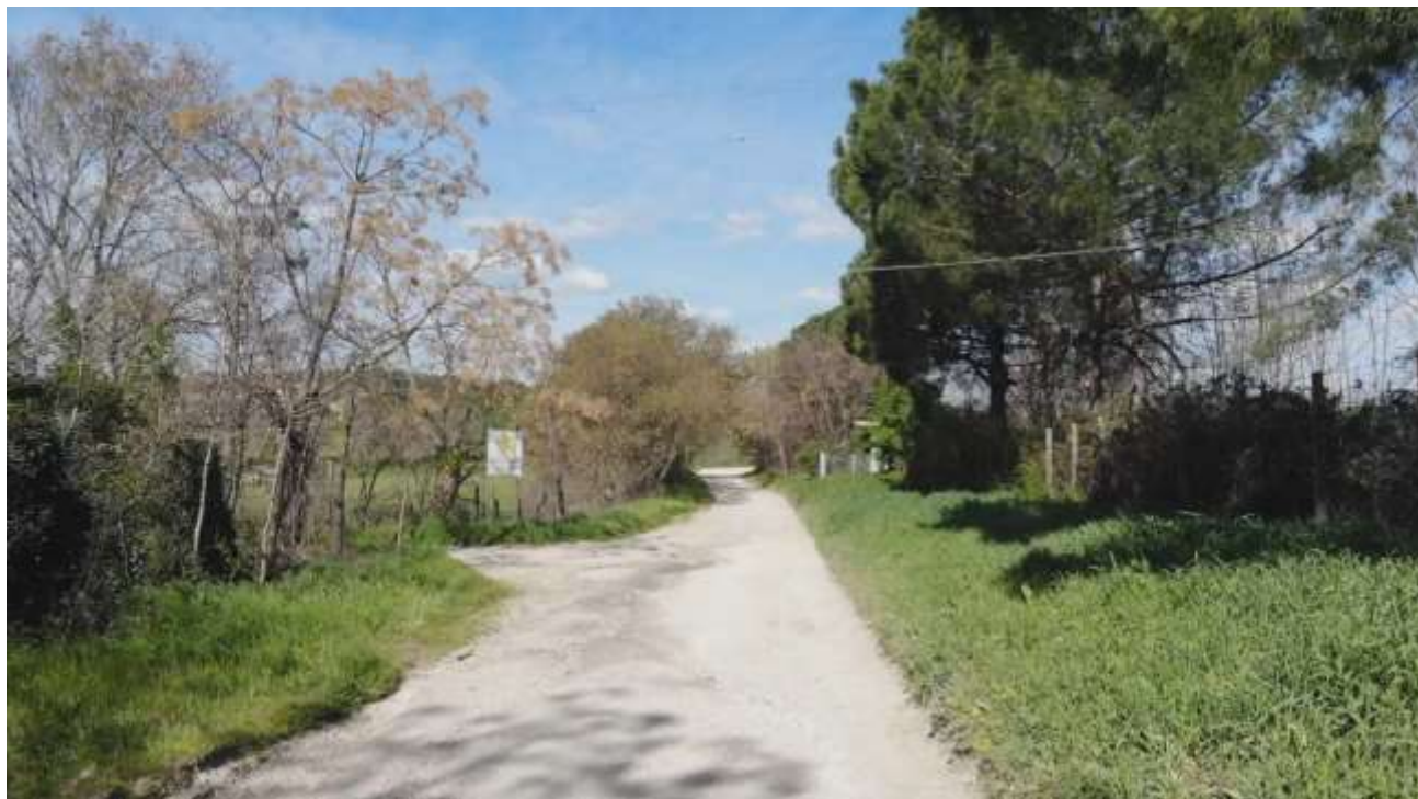
Figura 11 Stato attuale della via dell'Inviolata nel tratto da via di Casal Bianco verso l'impianto TMB di proprietà di Pontina Ambiente
