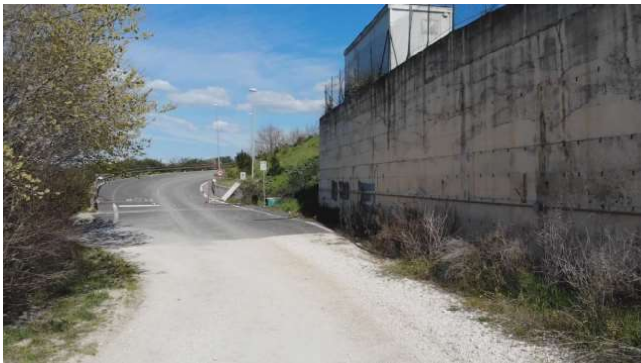
Figura 16 Stato attuale della via dell'Inviolata nel tratto da via di Casal Bianco verso l'impianto TMB di proprietà di Pontina Ambiente
